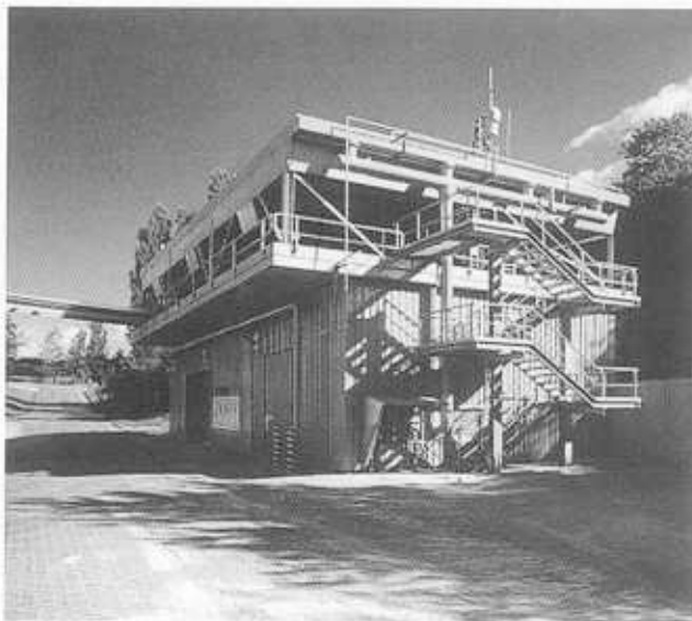
BILD 9: ORC-Gebäude und Luft-Kondensatoranlage FIGURE 9: ORC building and air condenser plant
